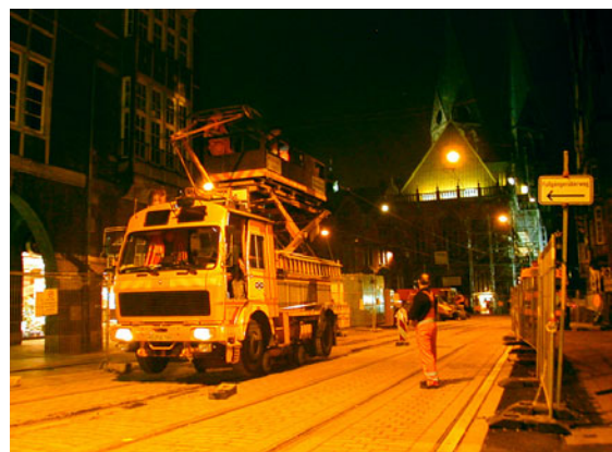
Køreledningsarbejde i Bremen
